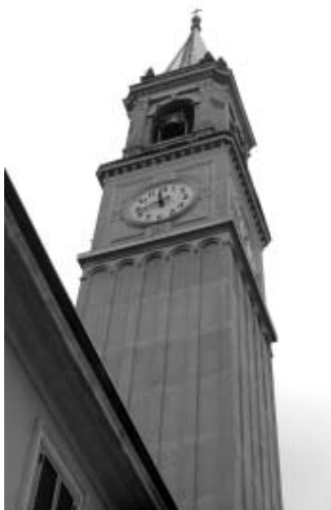
Le lesene che slanciano la struttura verso il cielo. A destra, facciata della chiesa. (photo Gianni Mazzenga)
