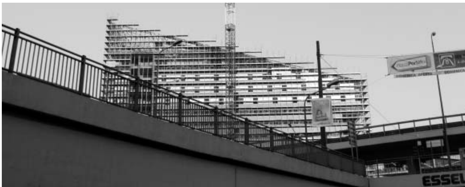
Cantieri al ponte della Ghisolfa.
