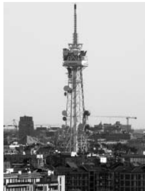
La torre trasmittente della RAI. (photo Franz della Valle)
